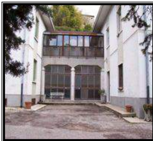
L'ingresso della casa di Castagnè
